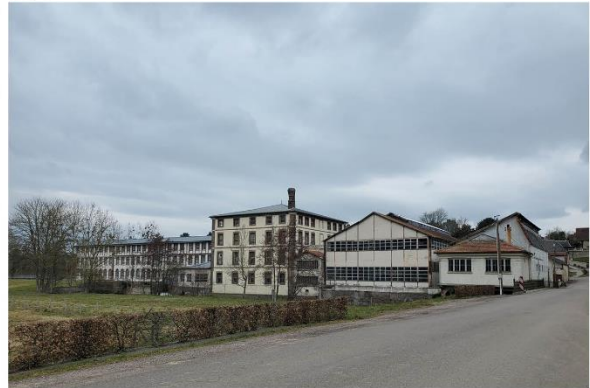
6 - Vue sur l'usine Bohin, route dit «le bourg» D293
